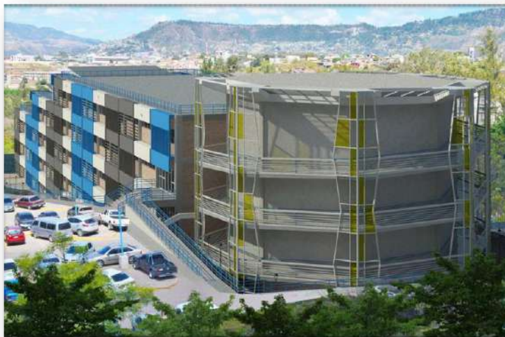
Edificio C3, Cuarto Piso, Ciudad Universitaria.
